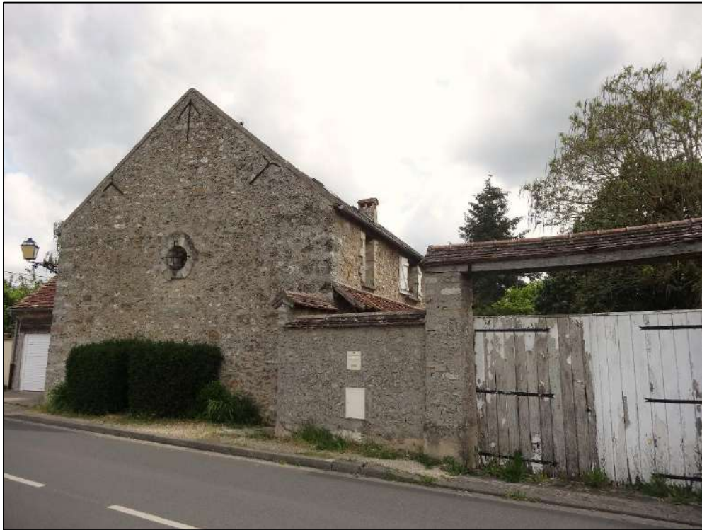
Ferme du 05 rue de la Fontaine, 2021
