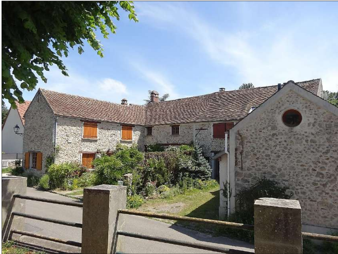
Cour commune du 01-03-03 bis de la rue de l'Orme Gras, 2021
