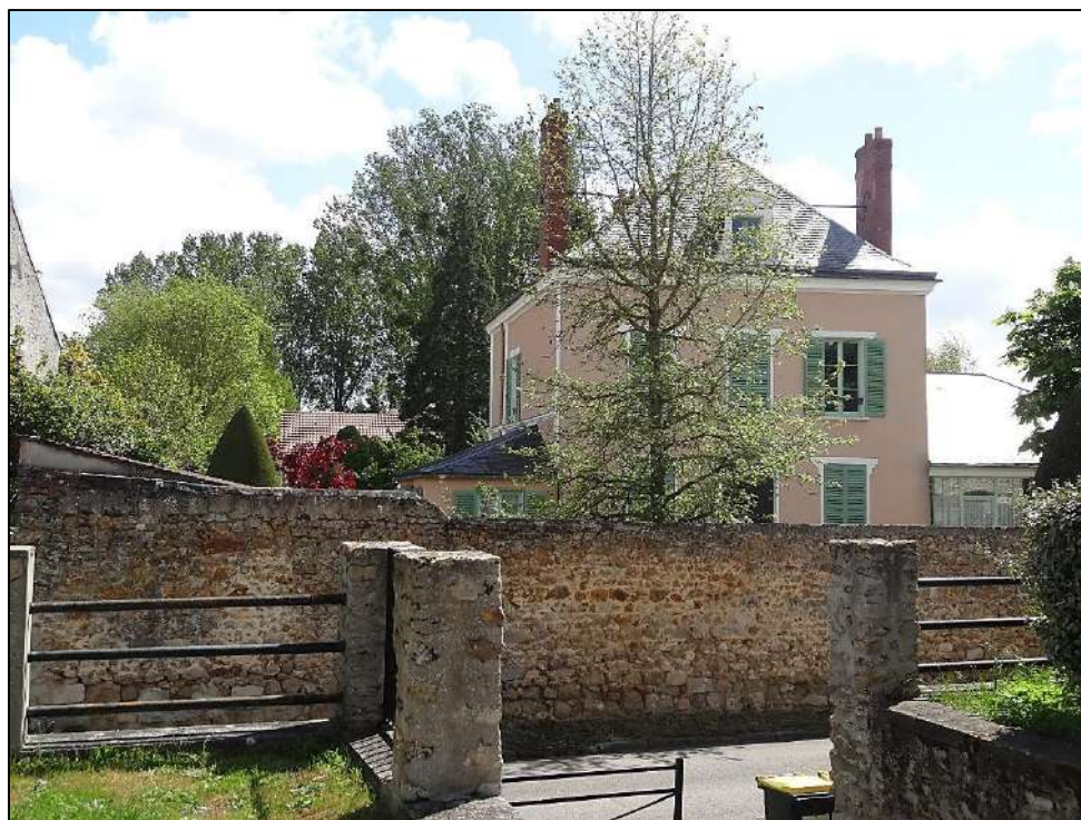
Villa dite la « Maison des Sœurs », 2021.
