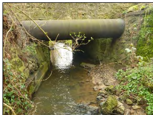
Vue vers l'aval
