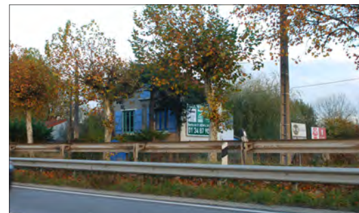
Absence totale de transition entre la voie et les habitations
