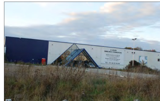
Bâtiment à l'abandon
