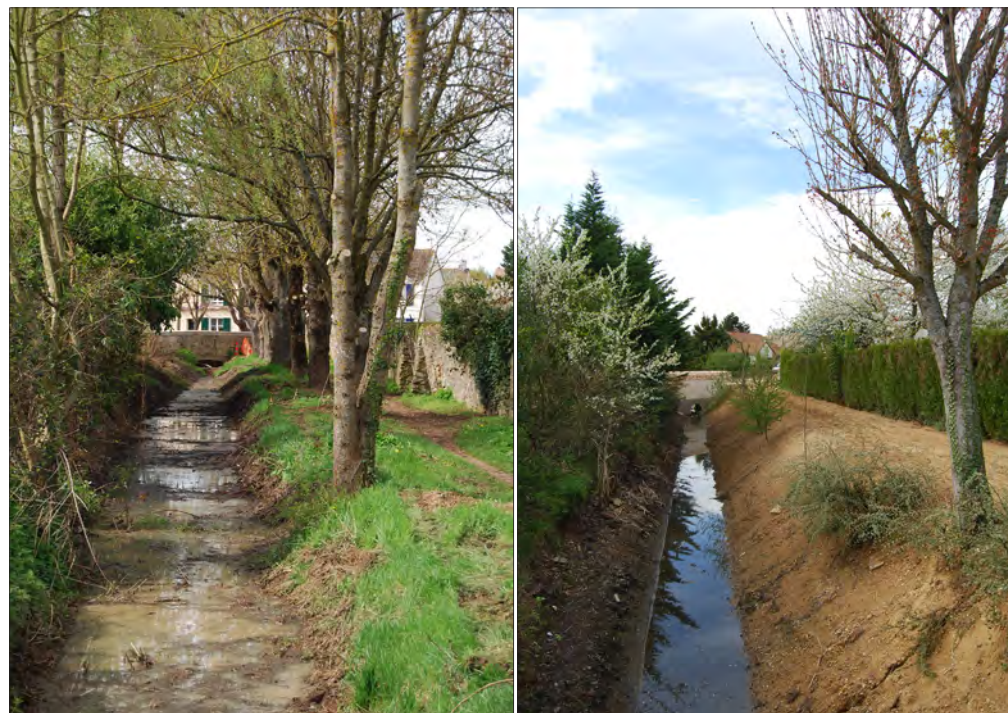
La rigole en cours de réaménagement, dans le centre de Châteaufort.
