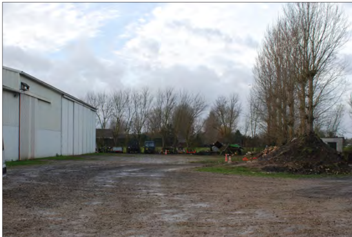
Grand espace central servant principalement à des usages techniques liés à l'exploitation.
