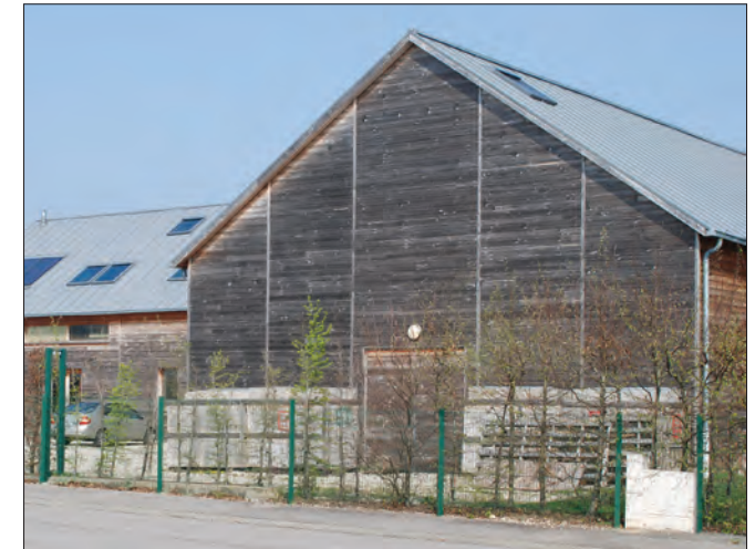
Nouveau bâtiment en bois de la ZA
