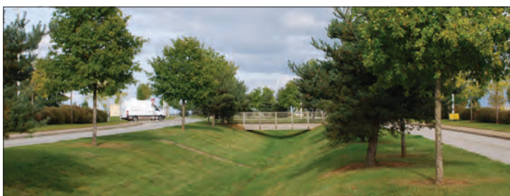
Les dispositifs de gestion des eaux pluviales contribuent à créer des espaces de qualité - ZA des Thévenardes à Chaumont (52)
