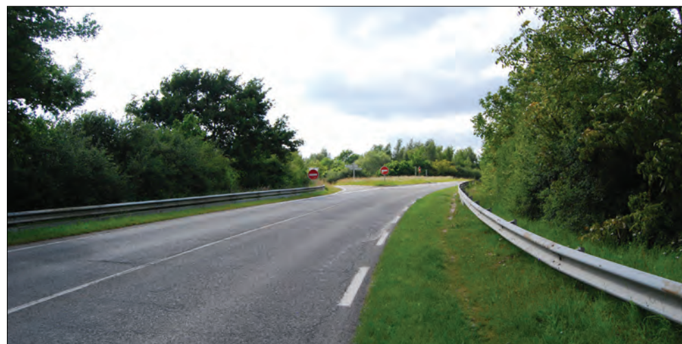
Absence d'aménagement pour piétons et cycles le long de la D155 : les circulations douces s'organisent entre la chaussée et l'espace enherbé.
