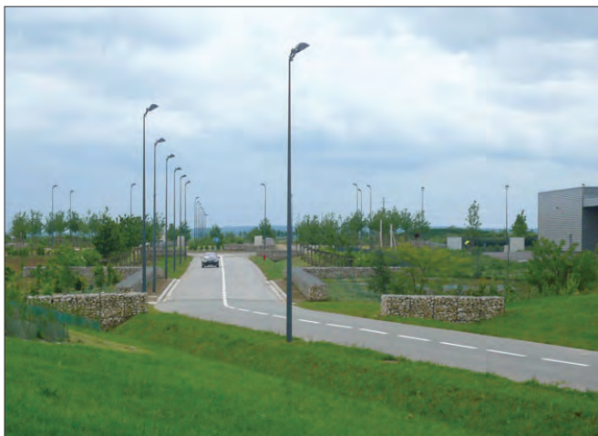
ZA Ploisy Courmelles - Agence HYL : La cohérence des aménagements et l'importance des surfaces végétales composent un paysage d'activité de qualité contrairement aux luminaires trop haut qui conduisent à la pollution nocturne
