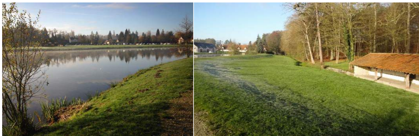
Saint Léger, étang communal. Le profil du plan d'eau est déconnecté de la Vesgre, les berges aspestisées
