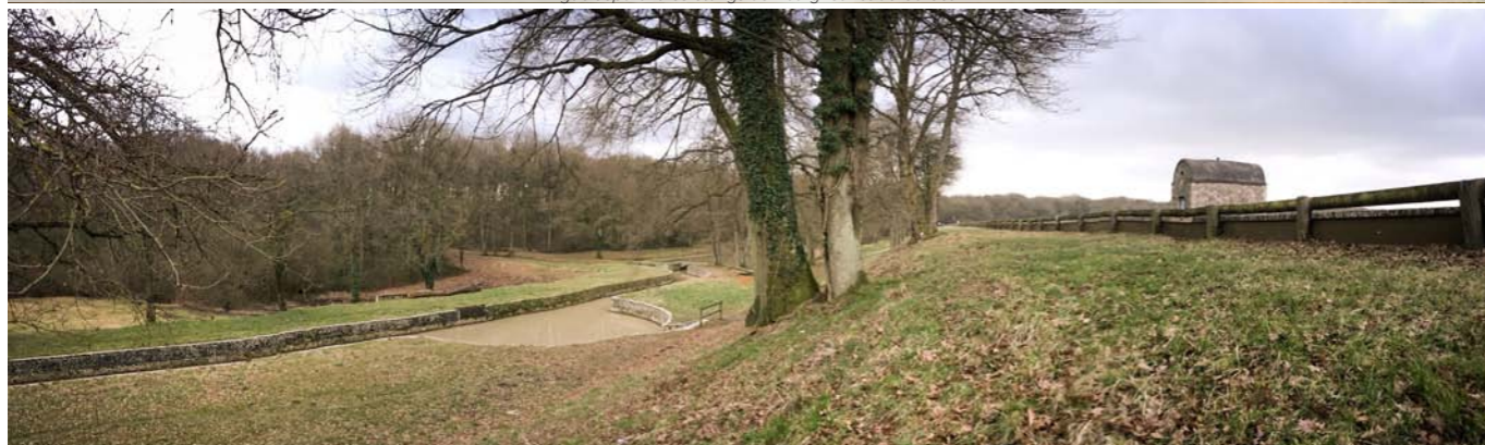
Chambre de soupape et haricots sous l'étang de St Hubert, Le Perray
