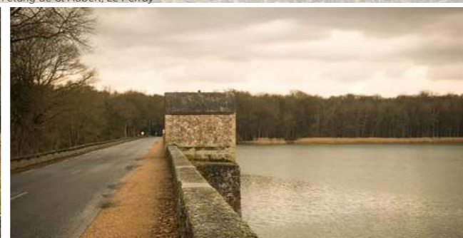
Chambres de soupape, sortie de l'étang de St Hubert, Le Perray
