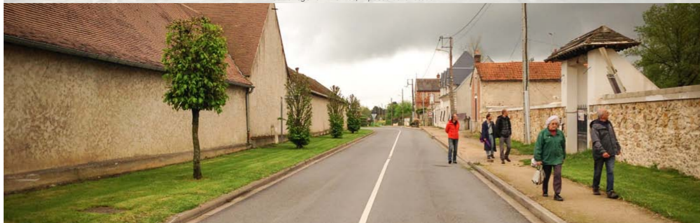
Les Bréviaires, le traitement paysager des espaces public de centre du village
