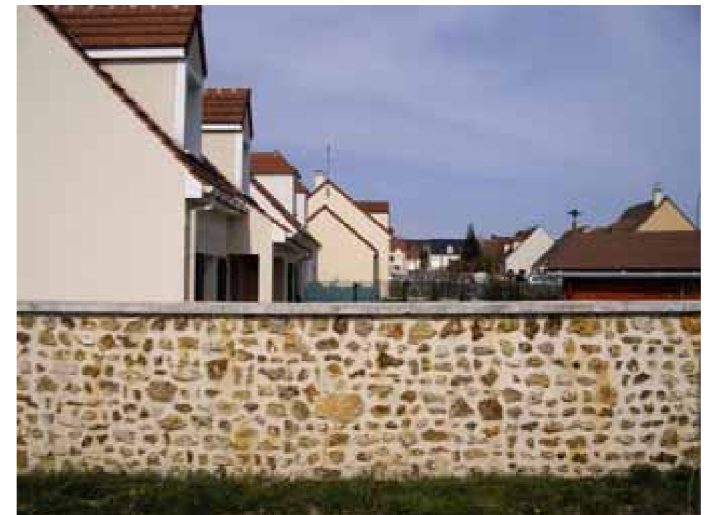
Parement de mur des lotissements de Gometz-la-Ville
