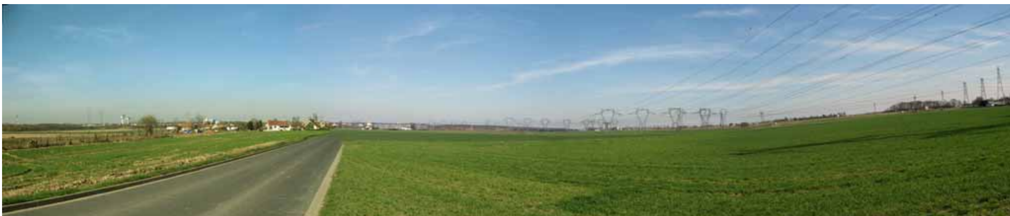
Champs de lignes électriques à Nozay
