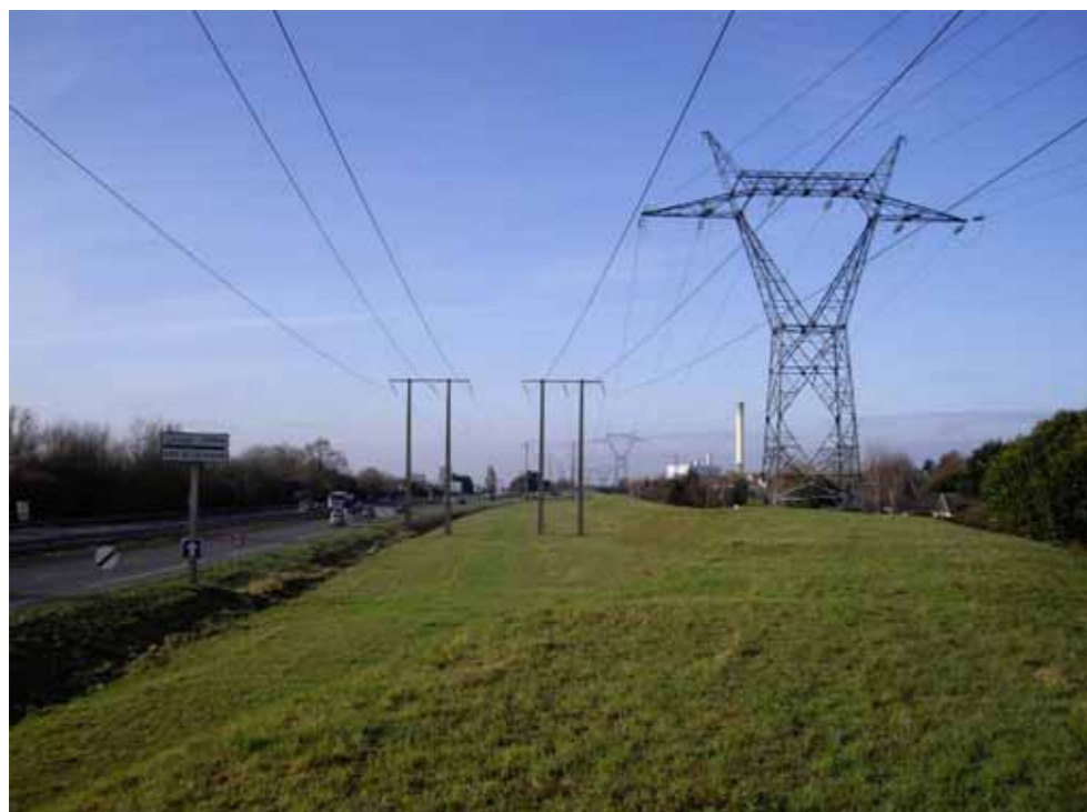
Les réseaux électrique qui s'installent dans les délaissés d'infrastructures
