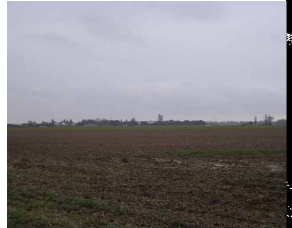
Les silos à grains de Limours
