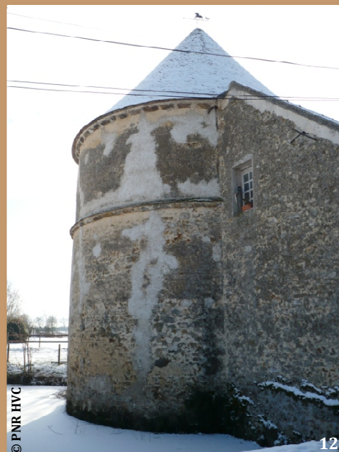
12 : Colombier , bâtiment entièrement destiné aux pigeons (le rez-de-chaussée pouvait être dévolu à d'autres activités). Les pigeons étaient nichés dans des « boulines » en partie supérieure. Le cordon mouluré visible en extérieur était destiné à stopper les belettes, prédateurs des pigeons.
