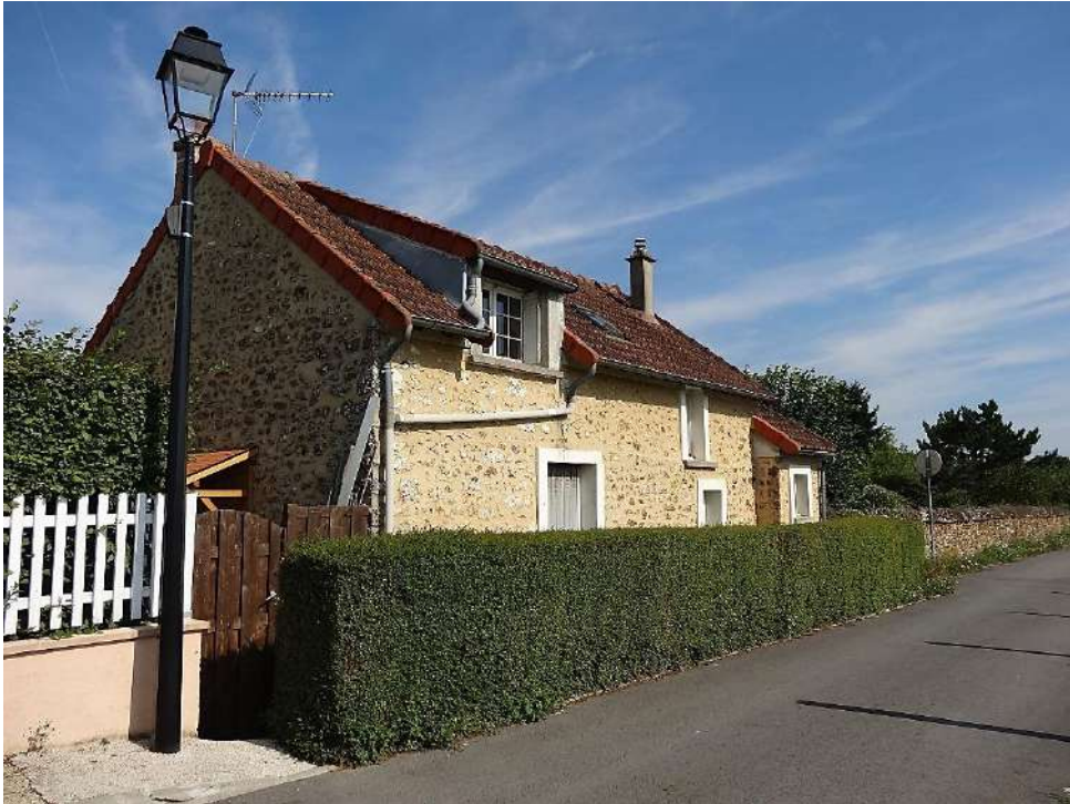
Maison rurale du 7 rue de la Folie Rigault, côté chemin, 2017
