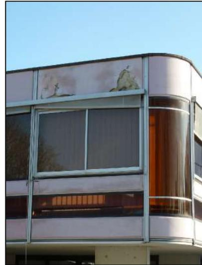
*Afin d'obtenir un maximum de luminosité, les surfaces vitrées sont très développées : outre les grandes baies coulissantes, les angles des unités de travail périphériques s'ouvrent vers l'extérieur par une plaque de plexiglas coloré, convexe ou concave, fixée par des bandes rivetées. De la même façon, les allèges des fenêtres sont ouvertes par un bandeau de plexiglas translucide. Un double système de stores, intérieur et extérieur, permet de moduler la lumière entrante.*
