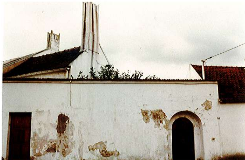
Maison -Lieu-dit de l'Erable
