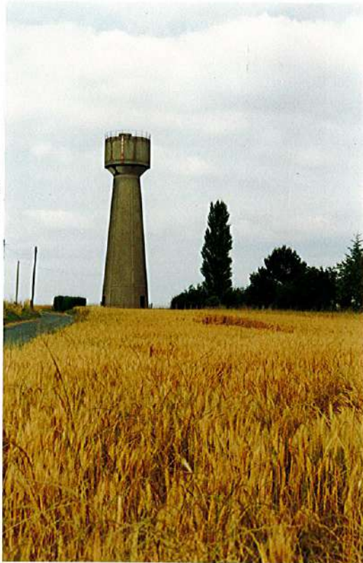
Château d'eau de Hautvilliers
