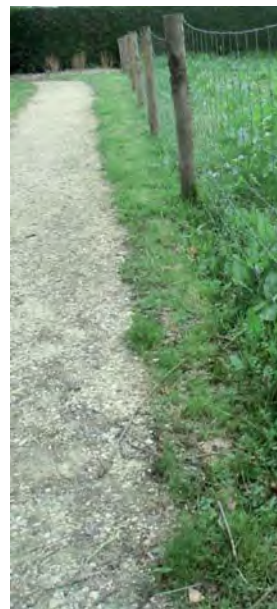
Chemin en grave concassée calcaire, potelet bois et ligne de pavés
