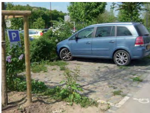
Parc de l'île Monsieur (Sèvres, 92) : pavés sur sable avec joints enherbés
