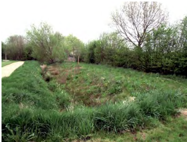
Exemple d'un fossé à Plailly (60) : avec pente adoucie sur un côté, une végétation de berge a pu être introduite et se développer.
