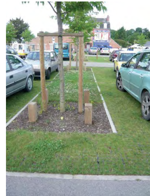
Saint-Valéry-sur-Somme (80) : alvéoles plastiques enherbées type ecogreen sous du stationnement
