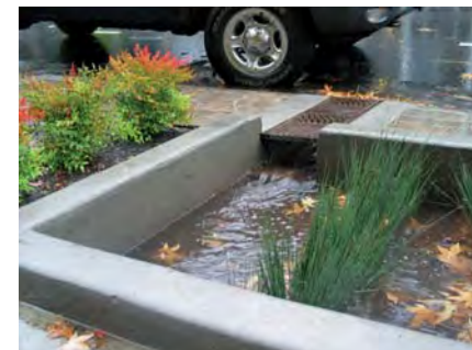
Exemple de traitement et d'infiltration des eaux pluviales en milieu urbanisé à Portland (US)
