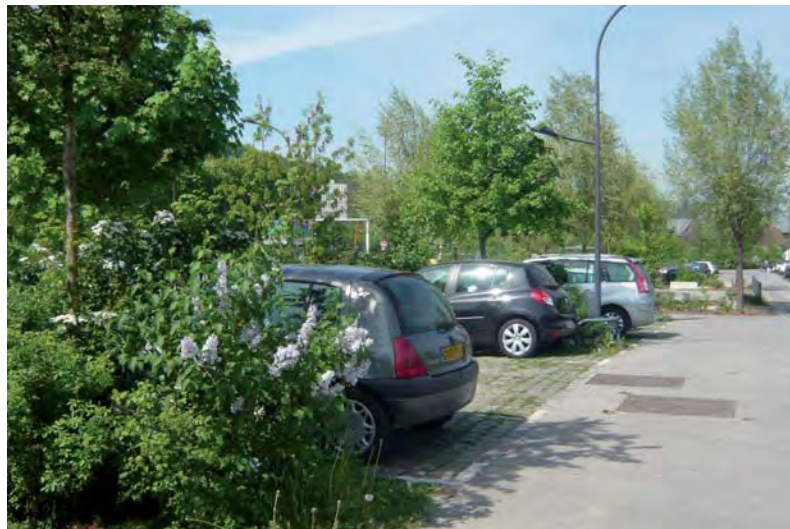
Exemple de traitement de sol pour du stationnement en pavés enherbés (parc de l'île Monsieur à Sèvres)
