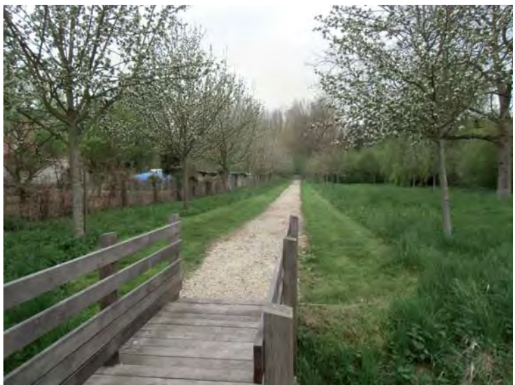
Passerelle bois sur un fossé, chemin en grave calcaire, gestion différenciée : tontes régulières des bords de chemin et fauche annuelle tardive dans le verger.
