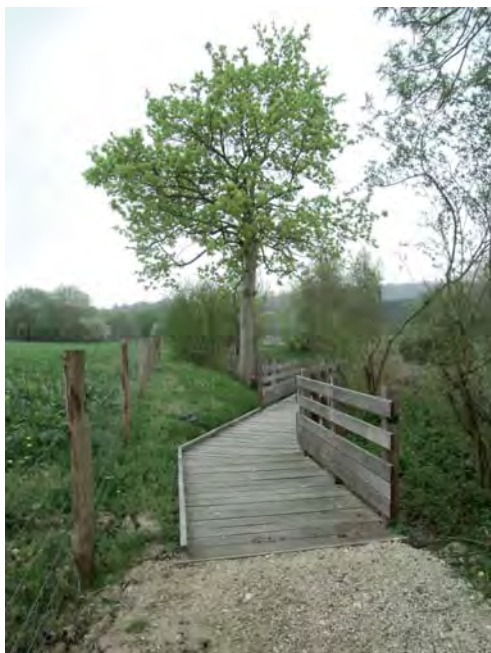
Platelage et passerelle bois aux abords d'un fossé afin de maintenir un passage dans l'emprise publique tout en ayant un accès piéton.
