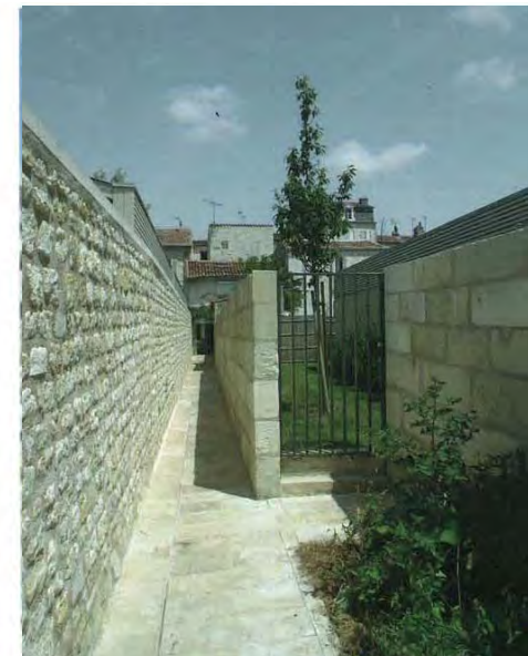
Venelle de desserte d'une parcelle donnant accès aux logements individuels, Saintes.
