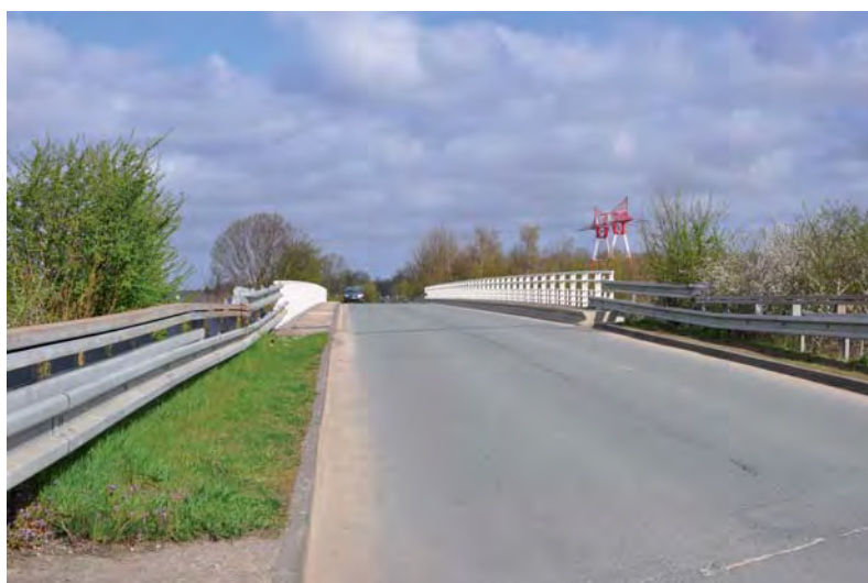
Ouvrage du Fresneau. Un effet de couloir © A. de Montjoye - O.G.E.
