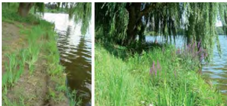
Mise en place d'un boudin d'hélophyte en fibre de coco sur le bas de berge (Möln, Allemagne) ©Aquabio
