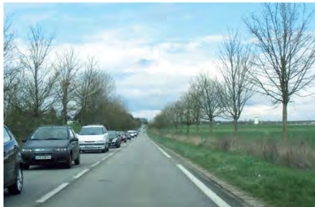
Route sur le plateau de Saclay : ligne pavée, fossé avec gestion extensive et alignement d'arbre font un bon exemple
