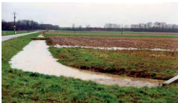
Plateau des Dombes à Beynost : drainage par de larges fossés en pente douce
