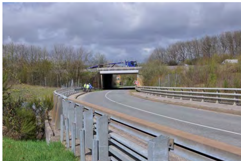
Ouvrage de Janvry. Au sud de l'ouvrage TGV (non visible, en remblai) jumelé à l'A10 (au second plan) : glissière sur une centaine de mètres © A. de Montjoye - O.G.E.
