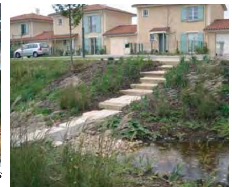
Exemple de traitement et d'infiltration des eaux pluviales en milieu urbanisé à Portland (US)
