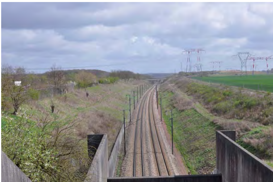
Talus de la ligne TGV : un potentiel de milieu prairial sur des centaines de kilomètres © A. de Montjoye – O.G.E.
