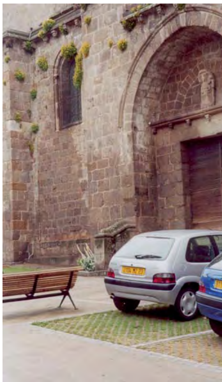
Exemple de stationnement traité en evergreen (alvéole béton et herbe) à proximité de l'église de La Souterraine (Creuse)
