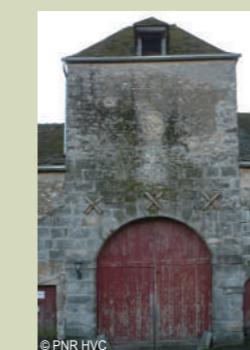
Pigeonnier aménagé dans les combles du porche d'entrée
