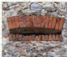
Ferme de l'Eglise, Longvilliers
