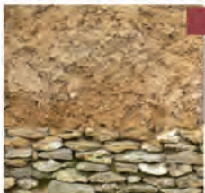
A l'ouest du Parc, certains éléments sont bâtis en terre crue selon la technique de la bauge. Seul le soubassement est en pierres, afin de préserver le mur de l'humidité. Mur de clôture, Gambais
