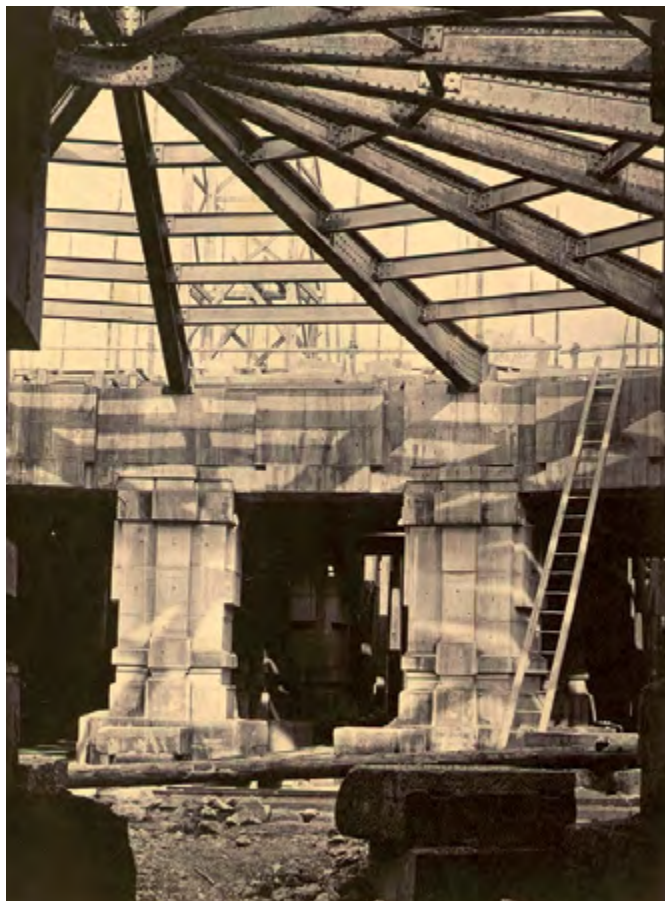
Structure métallique du plancher de l'opéra de Paris, 1864, Fonds Delmaet et Durandelle
